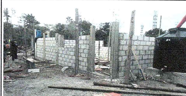
Foto 2: Proceso de Construcción.
