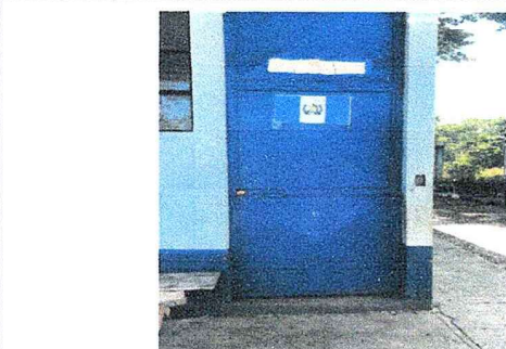
Foto 5: Avance de la colocación de chapas.
