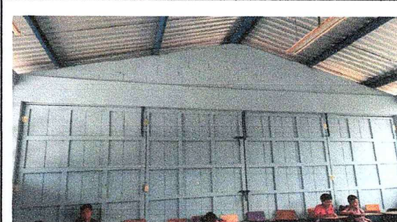
Foto 6: Avance de colocación de pasadores.
