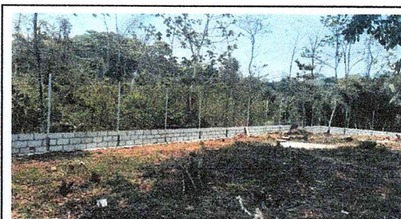
Foto 4: Avance del muro de contención
