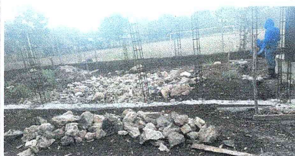
Foto 1: Inicio del levantamiento de la cocina
