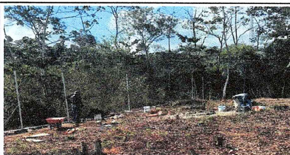
Foto 3: Inicio del muro de contención
